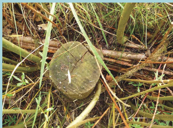
Figure 9. Exemple d'utilisation de corde de chanvre pour maintenir une couche de branches à rejet et de coco pour fixer une fascine.
