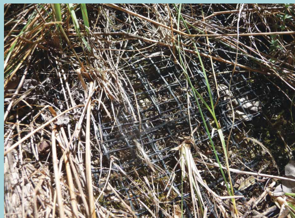
Figure 8. Exemple d'utilisation de géo-grilles plastiques pour la stabilisation de berges de cours d'eau.
